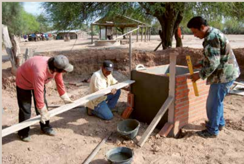
Ziegel für Ziegel: Neue Infrastruktur sichert Wasser in Dörfern, die monatelang ohne Regen auskommen müssen.
